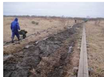
水抜き水路の埋め戻し
