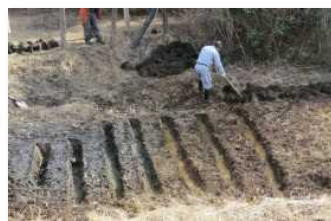
土砂堆積部分の浚渫
