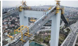
第1・第2ボスポラス橋 大規模修繕プロジェクト
