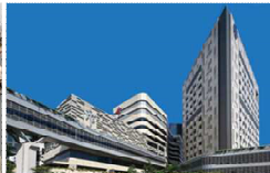
国立伝染病センター新築工事
