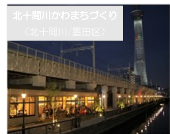
鉄道高架下施設『東京ミズマチ』
