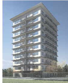
CLTを用いた10階建て共同住宅
