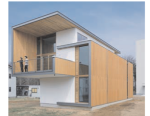
CLT工法による実験棟
