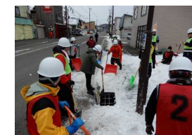
流雪溝への投雪作業
