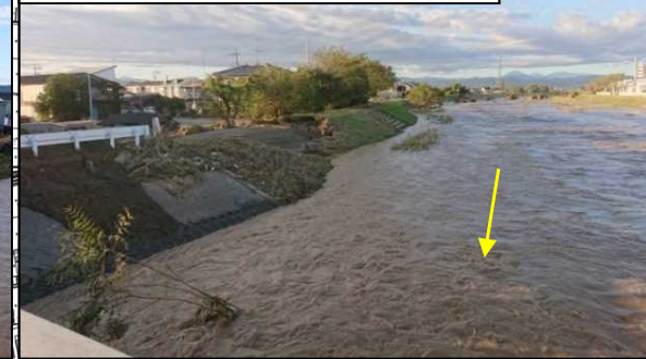
② 秋山川(大橋上流右岸)決壊箇所状況
