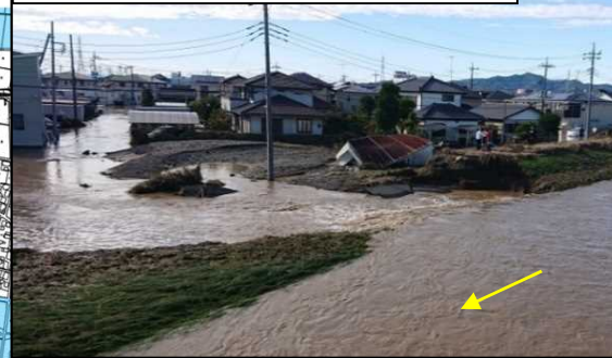
① 秋山川(海陸橋上流右岸)決壊箇所状況
