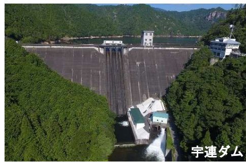
豊川用水施設 (水資源機構) S42完成
