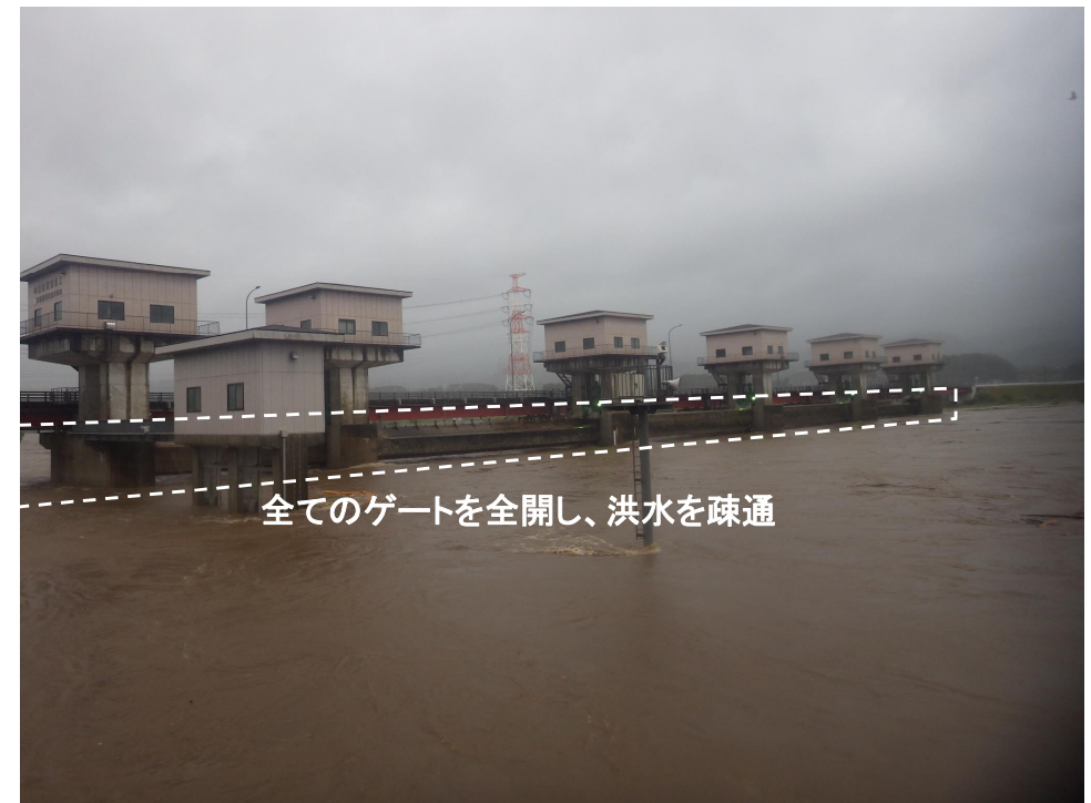
洪水時の牟呂松原頭首工
