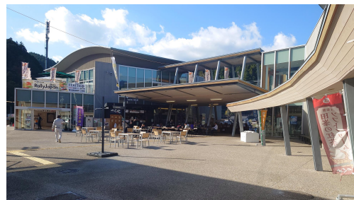
水源地域対策事業（道の駅したら）
