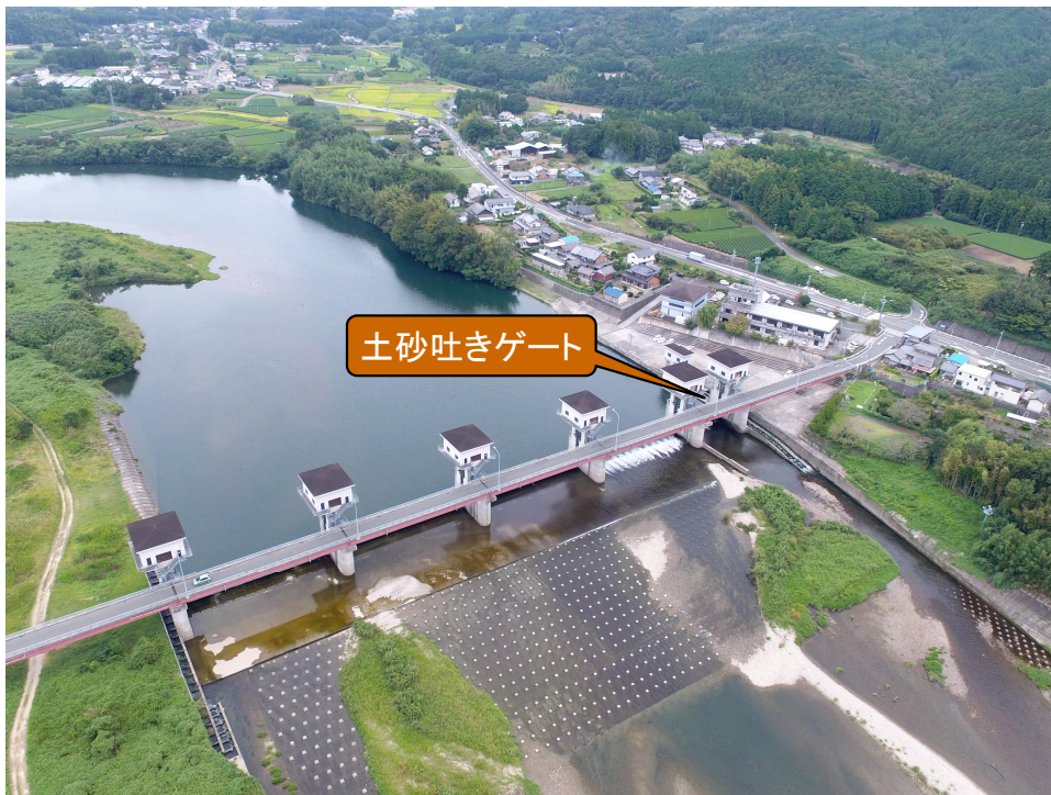
牟呂松原頭首工全景と土砂吐きゲート
