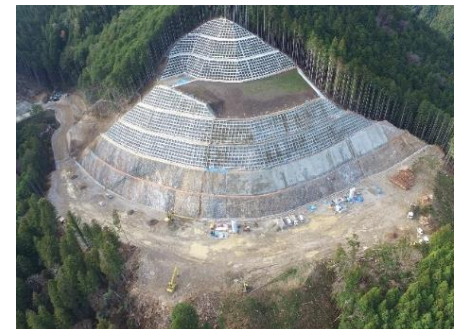
左岸頂部掘削
