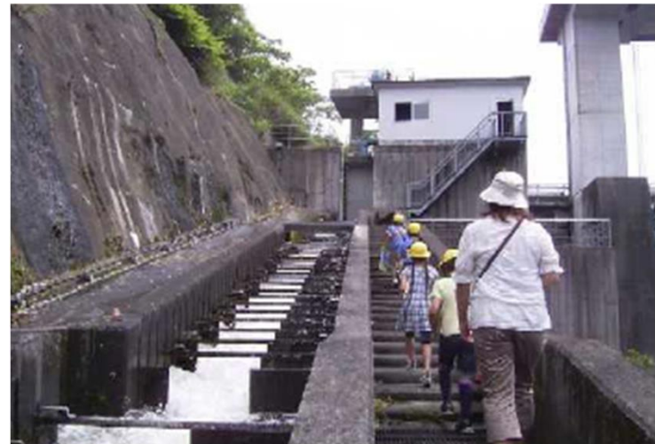
魚道の見学(大野頭首工)
