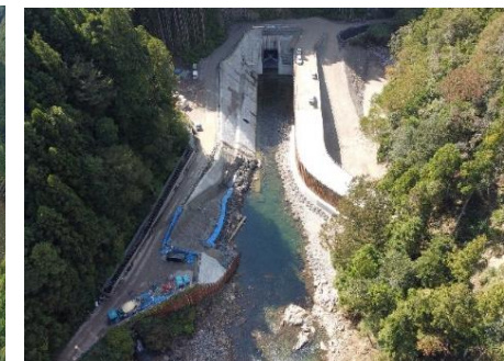
堤外仮排水路(呑口部)
