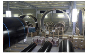
補修材等の備蓄状況((独)水資源機構)
