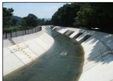
コンクリートライニング打換
