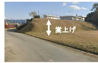
下条取水場・下条給水所の嵩上げ
