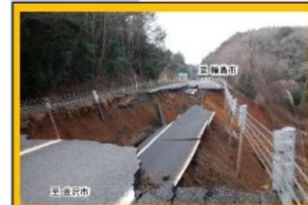
写真③ 能越自動車道の道路崩壊
