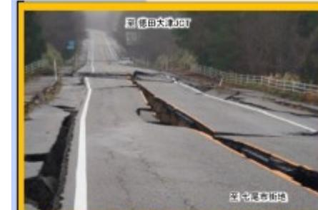
写真④ 能越自動車道の道路崩壊
