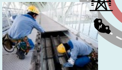
明石海峡大橋に添架されている電力ケーブル 出典) 関西電力送配電HP
