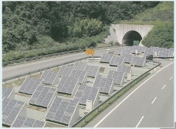
高速7号北神戸線 長坂山トンネル坑口付近
