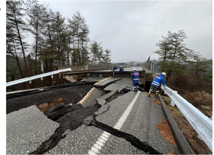
隣接構造物相互の影響を考慮すべき例 例：R6能登大橋接続部
