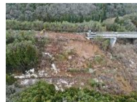
橋に接続している沢埋めの高盛土被災(能登大橋南側)
