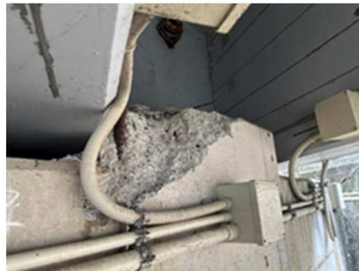
衝撃力によって、コンクリートが破壊され、遊間がひろがり、固定機能が変化した事例
