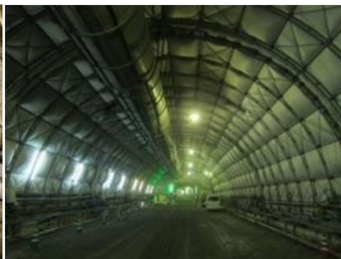
トンネル覆工の養生方法による 品質向上対策の例 (バルーン養生システム)
