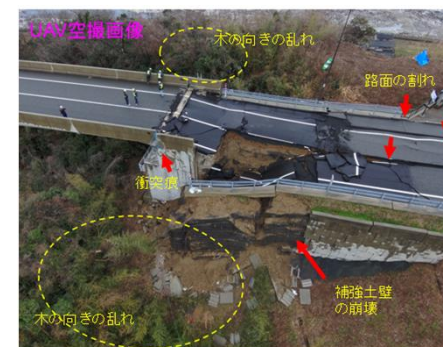
橋台周辺地盤の影響を受けて橋台が移動、残留変位が生じた事例
