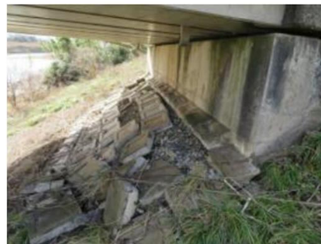
橋台周辺地盤の影響を受けて橋台が移動、残留変位が生じた事例
