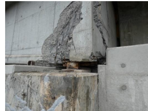
桁端と支承が同時に破壊した事例
