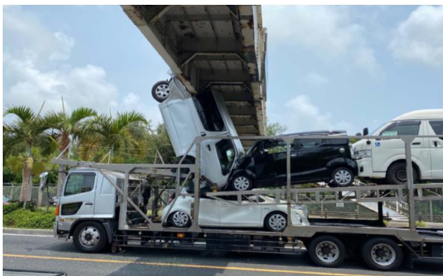
大型車両が歩道橋に接触した事故
