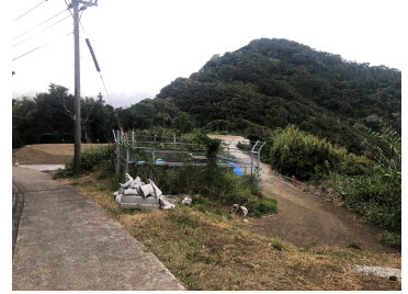
ヘリポート建設地
