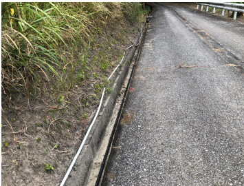
島内道路・水道管
