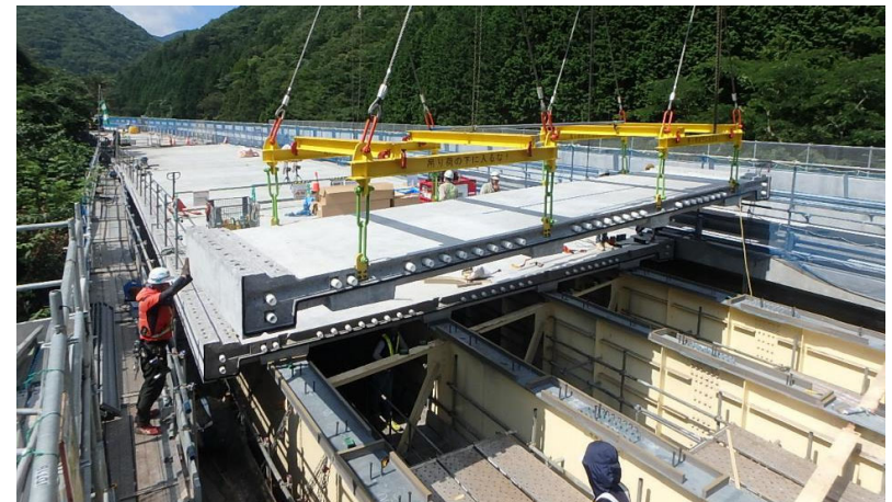
中国自動車道 蓼野第二橋 (2021年)
