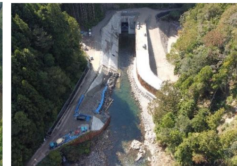
堤外仮排水路(呑口部)
