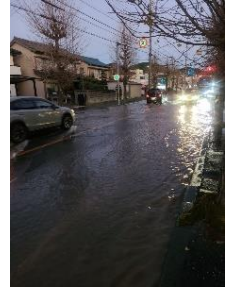
漏水による浸水
