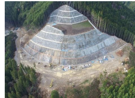
左岸頂部掘削
