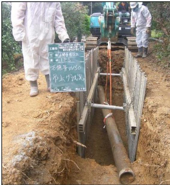
漏水・破損した石綿管の撤去
