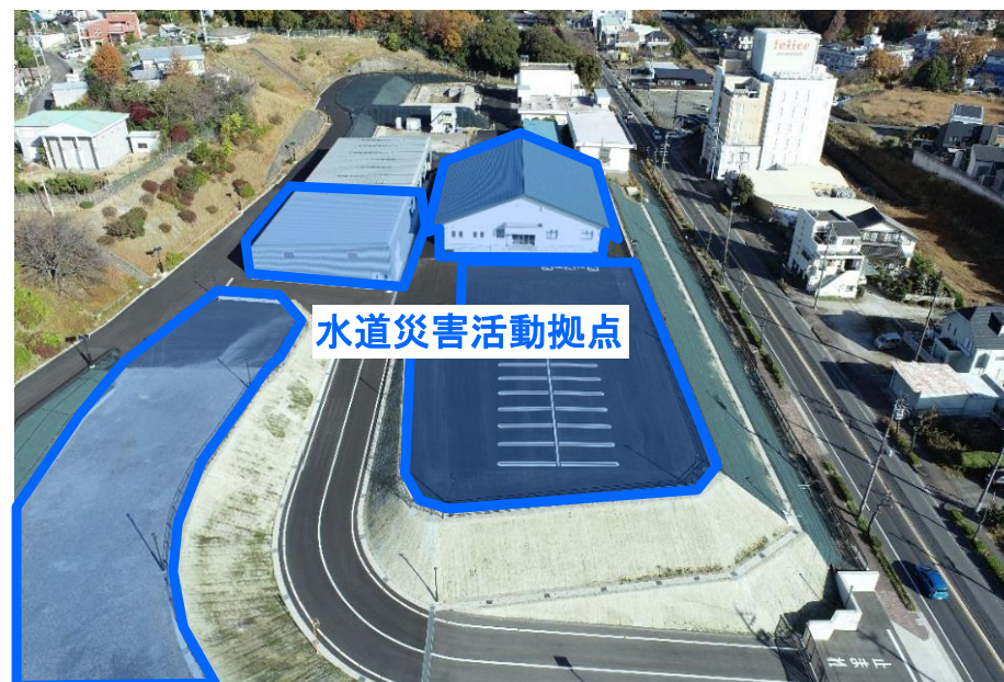
水道災害活動拠点 （愛知用水水道事務所尾張旭出張所）
