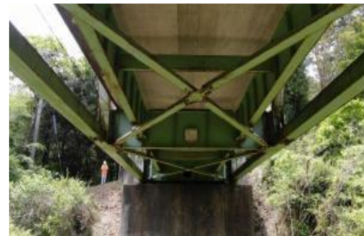
テスト飛行で撮影した橋梁の下面
