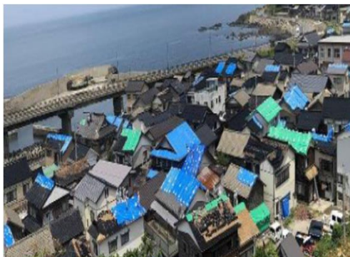
住宅の屋根瓦の落下
