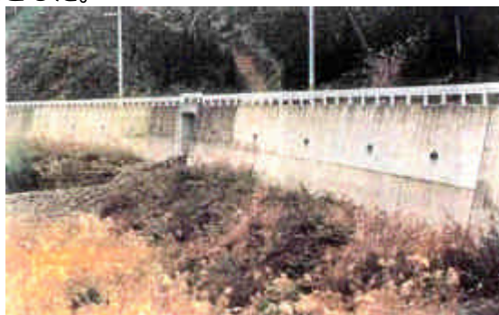
図 路側擁壁に設けたくぼみ
