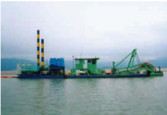
図 浚渫船作業状況
