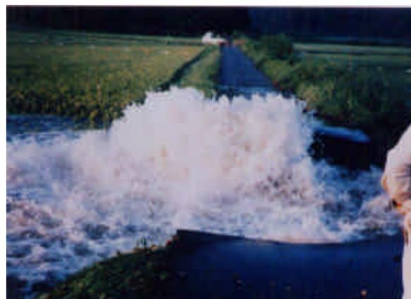
PC管破裂による出水状況
