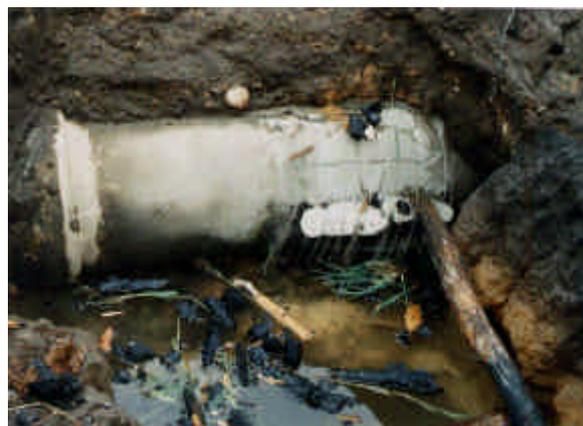
PC管破裂状況
