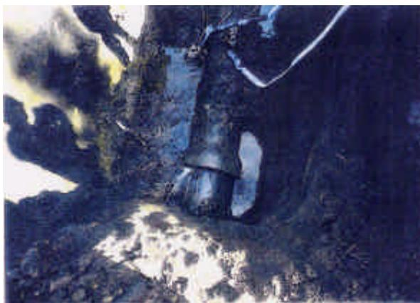
PC管漏水状況 (継目からの漏水)
