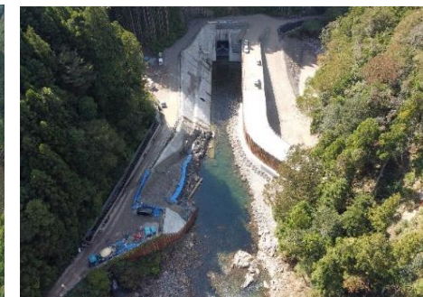
堤外仮排水路(呑口部)
