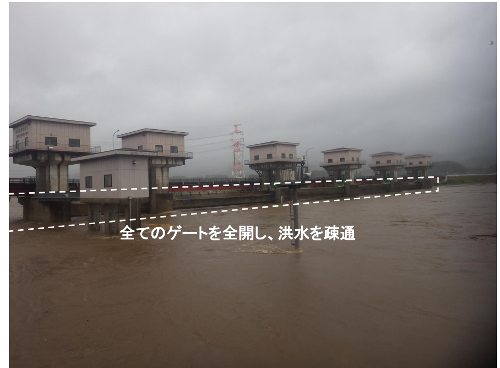
洪水時の牟呂松原頭首工
