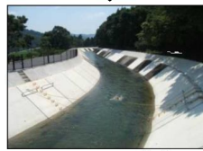
コンクリートライニング打換
