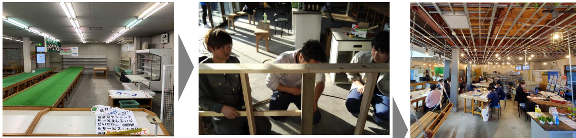
<町民と関係人口らで施設の改修を行った>
