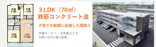
< PFI 方式による境町定住促進住宅 >
