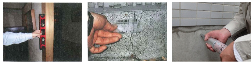
水平器による柱の傾きの計測 クラックスケールによる基礎のひび割れ幅の計測 コンクリートの圧縮強度の測定
