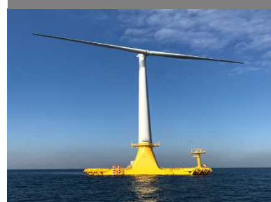
洋上風車の浮体基礎
