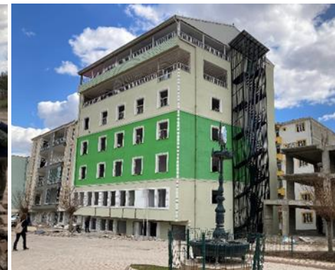
地盤沈下による被害
