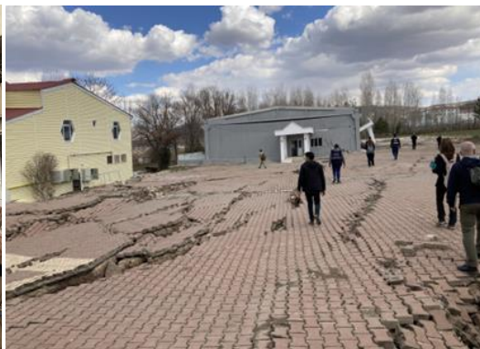
地すべりによる被害
