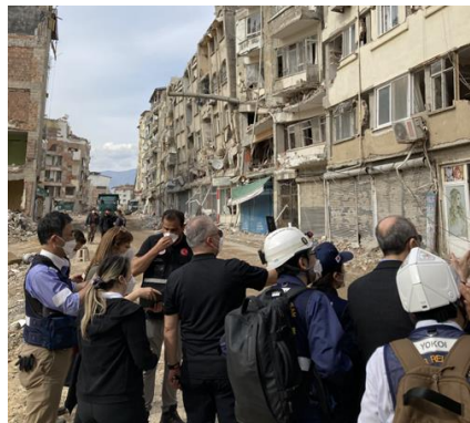
軟弱な地盤上の建物の被災
