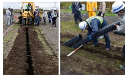
トレンチャーによる細溝掘削断面の管路敷設試験
