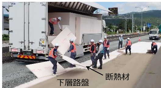
断熱材の施工状況
