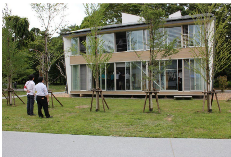
写真-I-1. 2. 10 LCCM 住宅デモンストレーション棟
