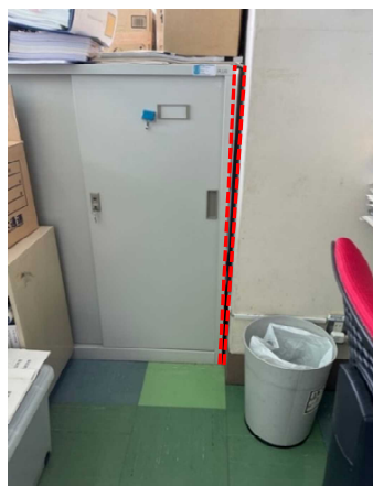
5F事務室(事務室窓側共通) : 外周部スラブが傾斜している
