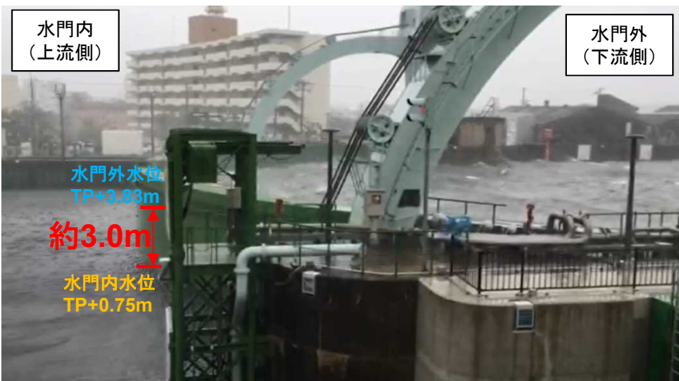
台風第21号による高波来襲から市街地を守る木津川水門 (平成30年9月4日)
