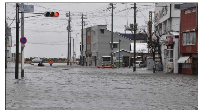
高潮による浸水 (北海道根室市)
