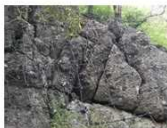
落石防護網の設置や落石の除去
