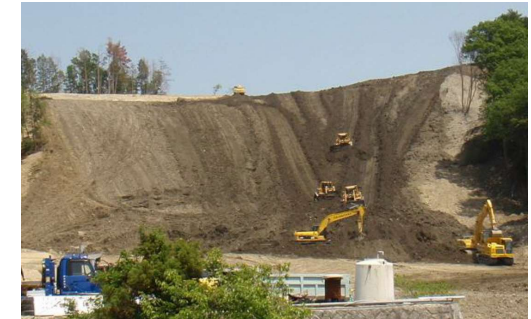
盛土撤去工事のイメージ
