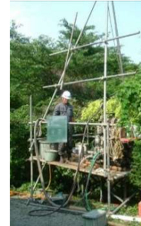
安全性把握調査 (ボーリング調査)
