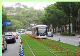
軌道敷緑化の整備 (熊本県熊本市)
