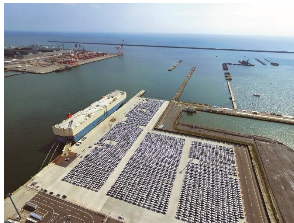
整備が進む茨城港常陸那珂港区
