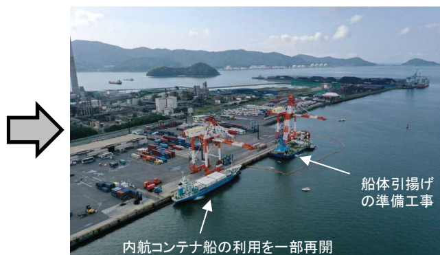
内航コンテナ航路の一部利用再開 (8月9日から。写真は8月22日)
