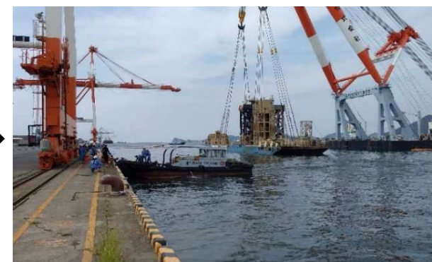
船体引き揚げの状況(8月29日)
