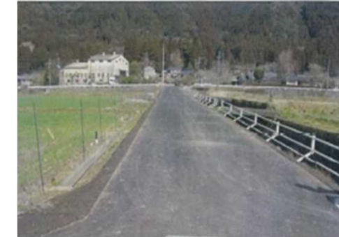
ほ場整備（農道）事業（小石原川ダム）
