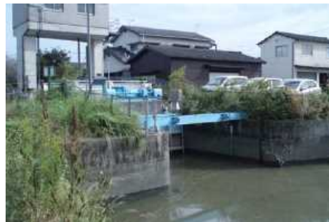
田川城島2号排水樋門
