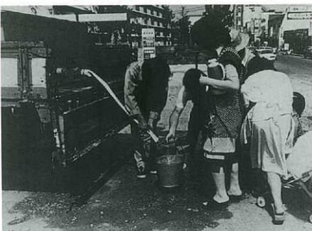
給水車が出動 (S53年渇水)
