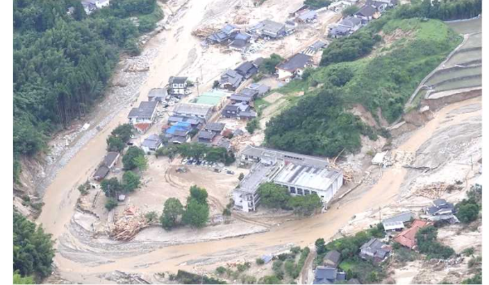
平成29年7月洪水 (赤谷川の氾濫:福岡県朝倉市)
