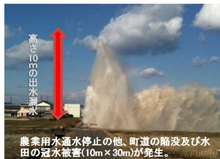
漏水による周辺陥没状況
