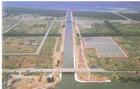
石狩放水路完成(S57)
