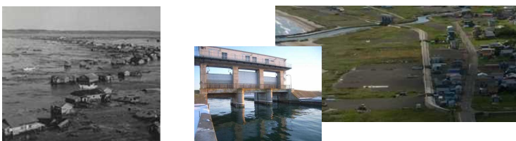
昭和35年チリ沖津波による被害状況 浜中町の防潮水門・防潮堤
