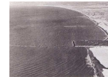
昭和35年頃の苫小牧港 西港の内陸掘込みを開始
