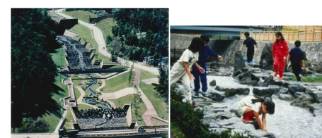
十勝岳流路工 国立公園の良好な景観に配慮した整備を全国に先駆けて実施
