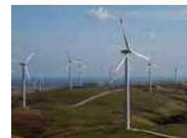
宗谷岬ウインドファーム 運営: (株)ユースエナジー宗谷 操業: 平成17年11月 設備容量: 57,000kW
