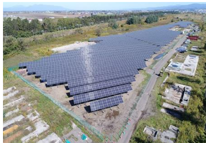
岩見沢太陽光発電所
