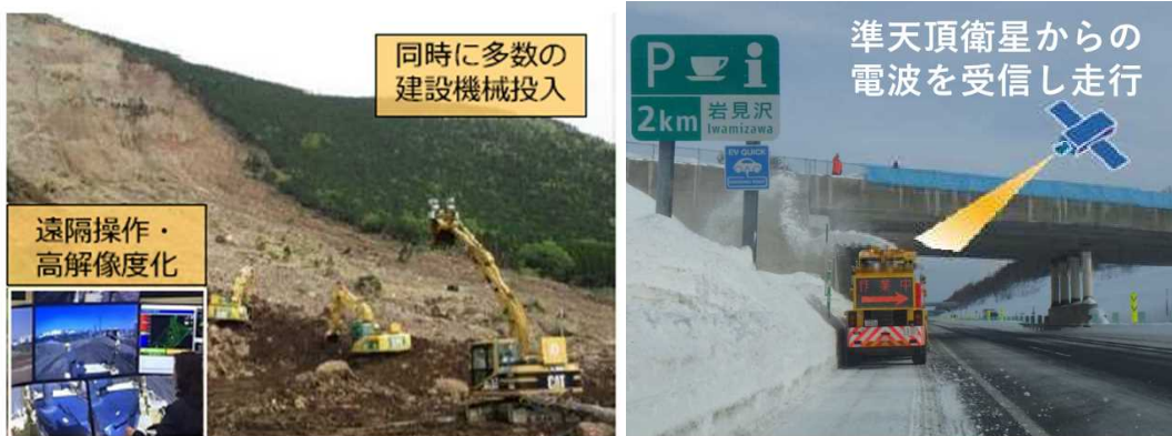
5Gを活用した無人化施工(イメージ) 道央道でのICT除雪技術の実験状況
