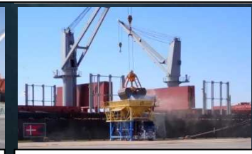
木質ペレット荷役作業(4/2)
