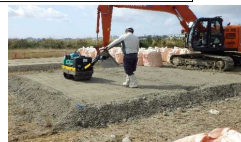
試験体の敷均し・転圧の様子
