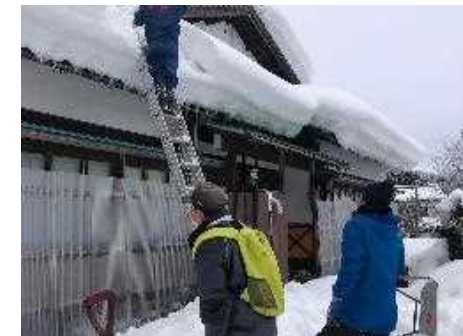
屋根雪下ろし作業の実施
