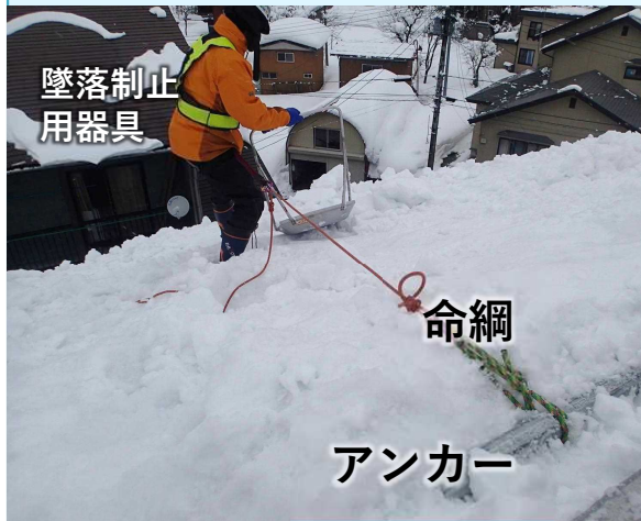
命綱固定アンカーに命綱を固定して雪下ろしを行う様子
