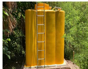
■高架水槽改良
