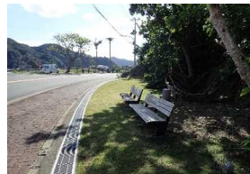
出入口の老朽化
