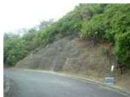
落石防護網整備後
