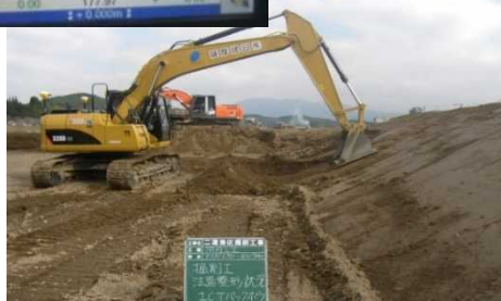
ICT建機による施工 (丁張無しで工事)
