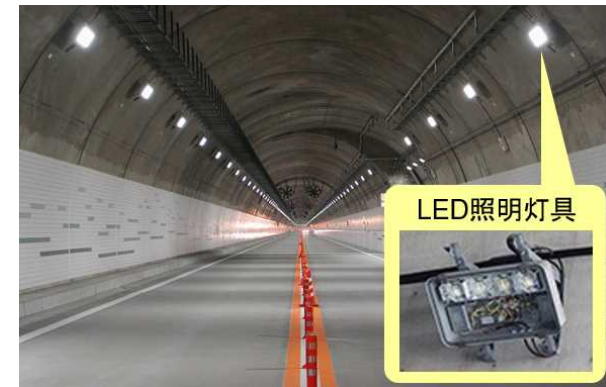
中部縦貫自動車道
