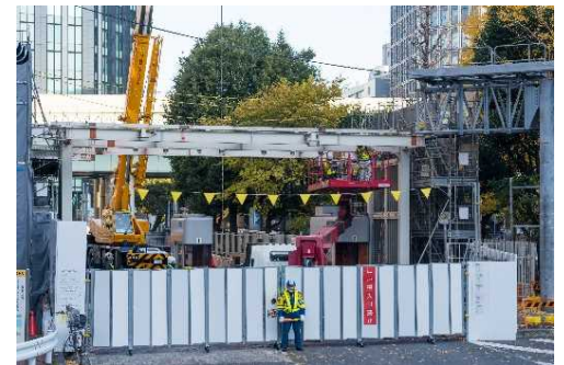
写真③ 料金所撤去状況 (江戸橋入口)
