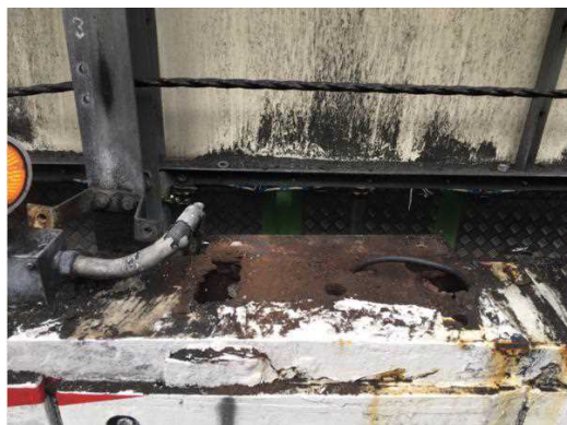
照明柱が設置されていた高欄上面
