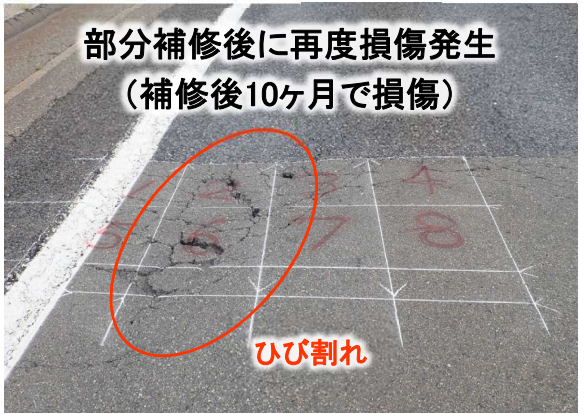
上層路盤下面からのひび割れ状況
