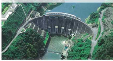
比奈知ダム(水資源機構)H10完成
