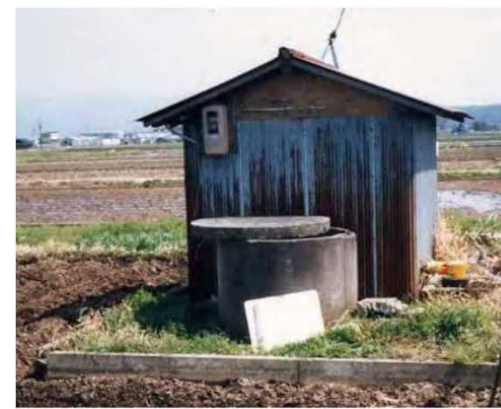
地域内に点在する地下水揚水ポンプ
