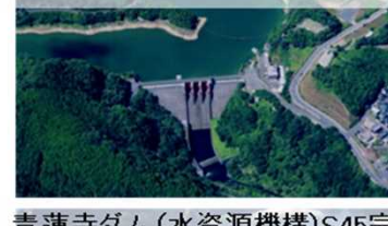
青蓮寺ダム(水資源機構)S45完成
