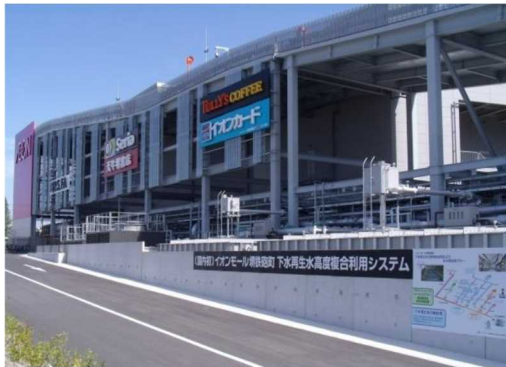
熱源利用する大型商業施設
